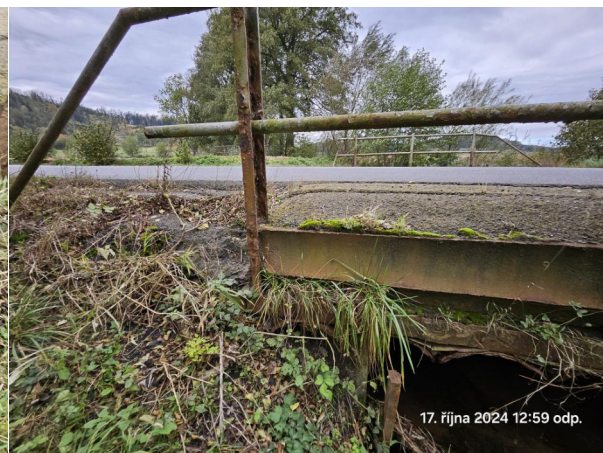
Nenormová konstrukce zábradlí.
