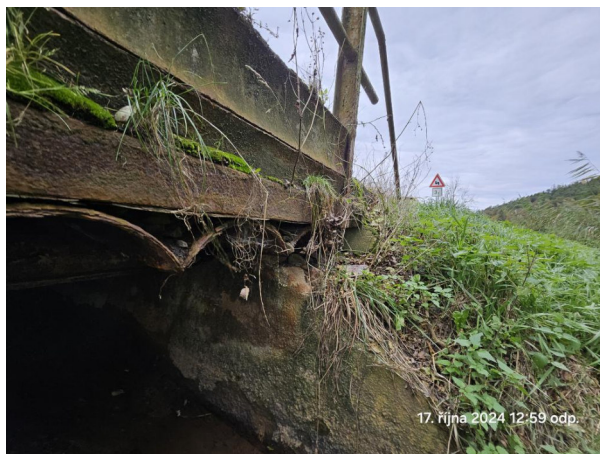
Degradace a rozpad betonů OP1.
