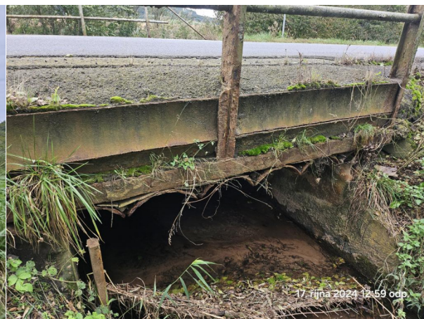
Koroze ukotvení zábradlí.
