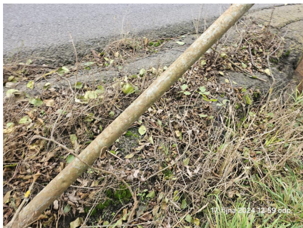
Nenormové zakončení zábradlí.
