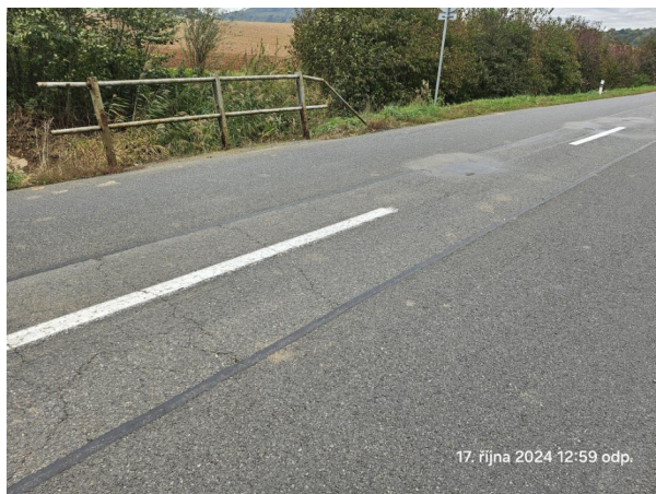
Poruchy v krytu vozovky.
