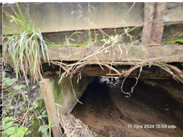
Plošné znečištění NK.
